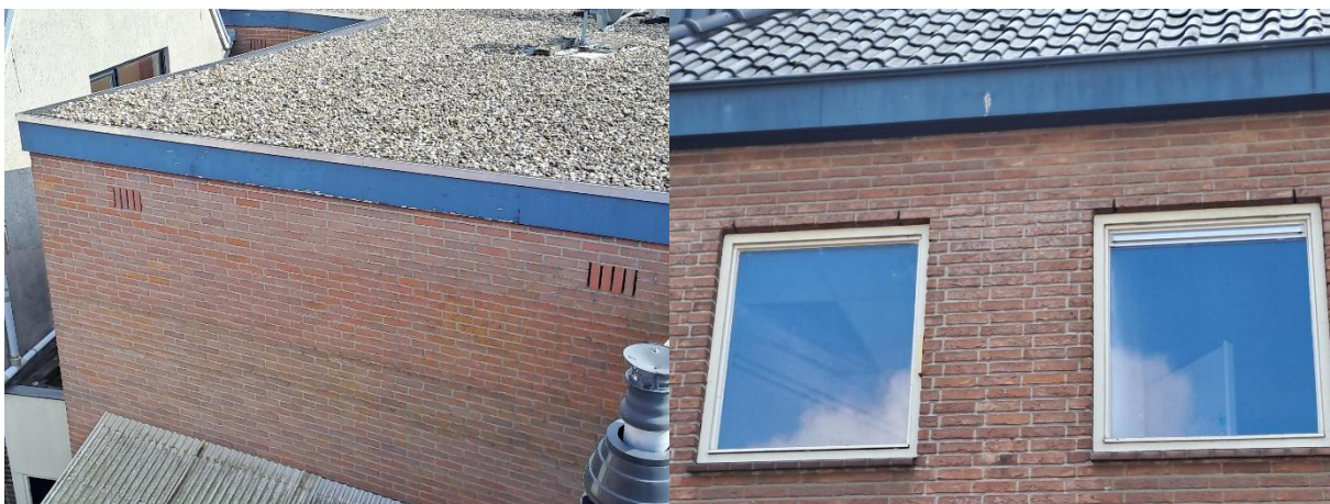
Foto links; ventilatieopeningen bieden een invliegopening naar de spouwmuur. Foto rechts; Openstootvoegen in het metselwerk bieden een invliegopening naar de spouwmuur.
