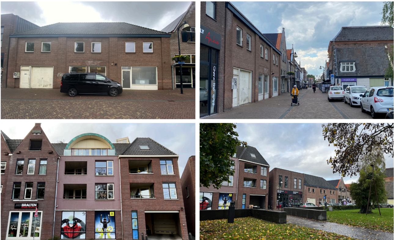
Afbeelding 2.2: Foto's bestaande toestand Touwstraat (Bron: Google Maps)
