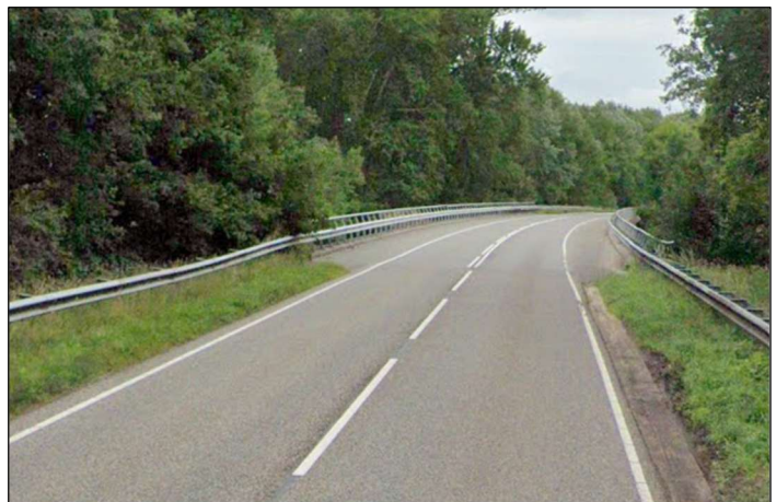
Figuur 4: Viaduct Oosterbroekenweg Meppel (Google Earth, 2025).
