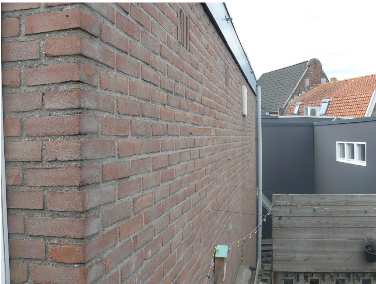
Hoofdstraat 15 Meppel: achtergevel ter hoogte van de verdieping, juli 2025.
