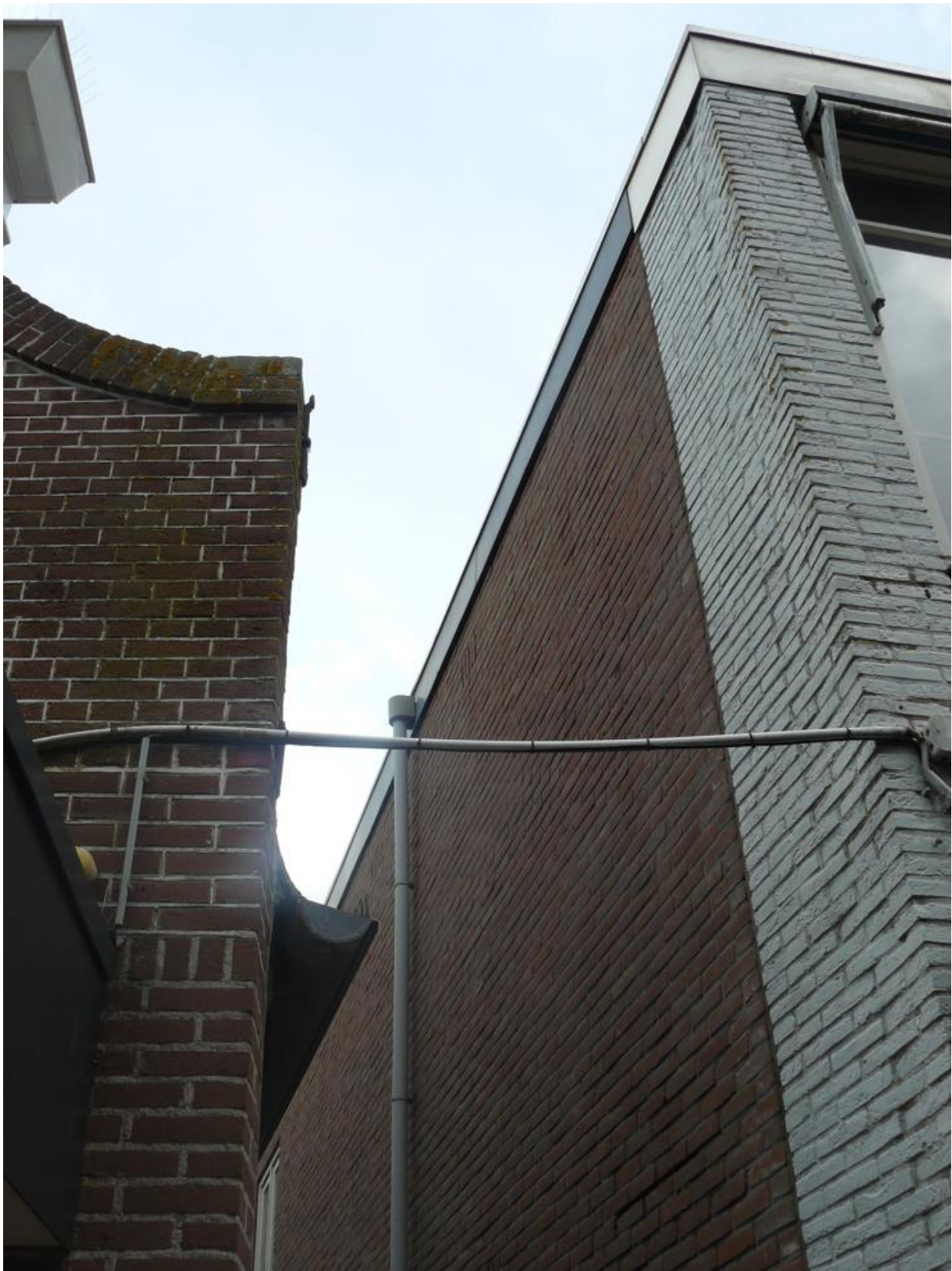
Hoofdstraat 15 Meppel: hoek noordwest met linker zijgevel, juli 2025.
