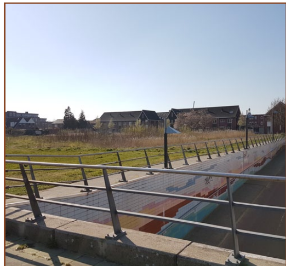
Afb. 2.3: Foto vanaf de fietserstunnel aan Het Vledder.
